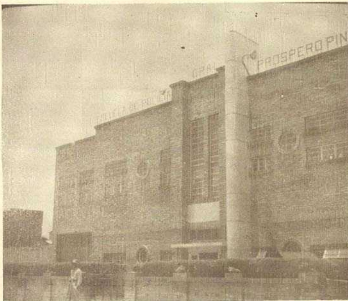
Fachada de la Escuela de Policía "General Próspero Pinzón".
